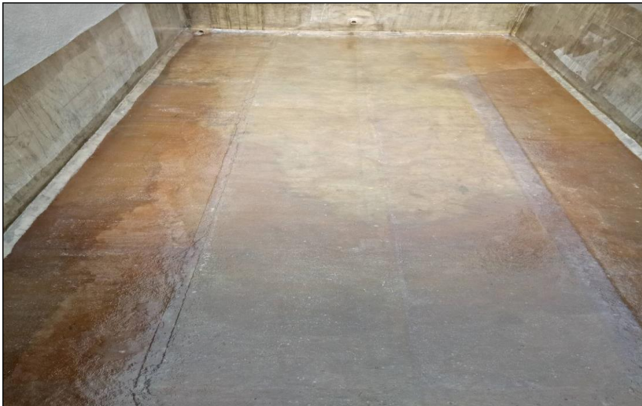
ภาพหลังเสร็จงาน
