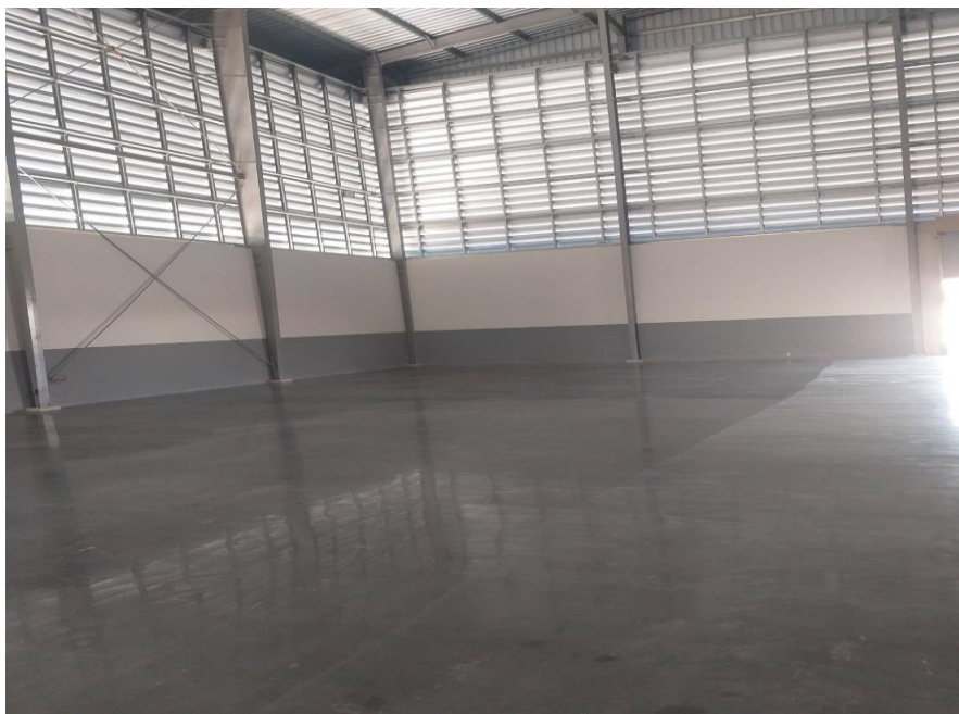
ภาพหลังเสร็จงาน
