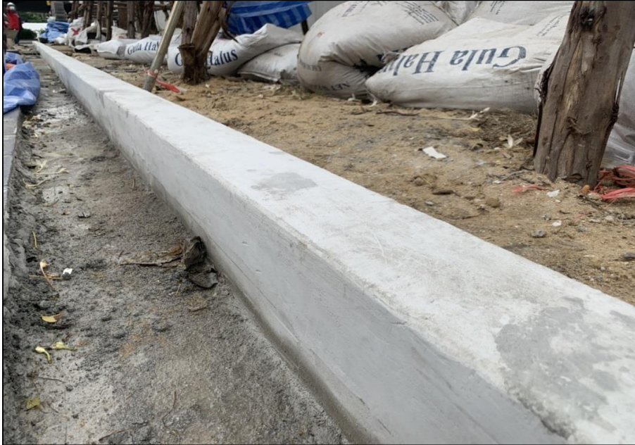
ภาพก่อนทำงาน
