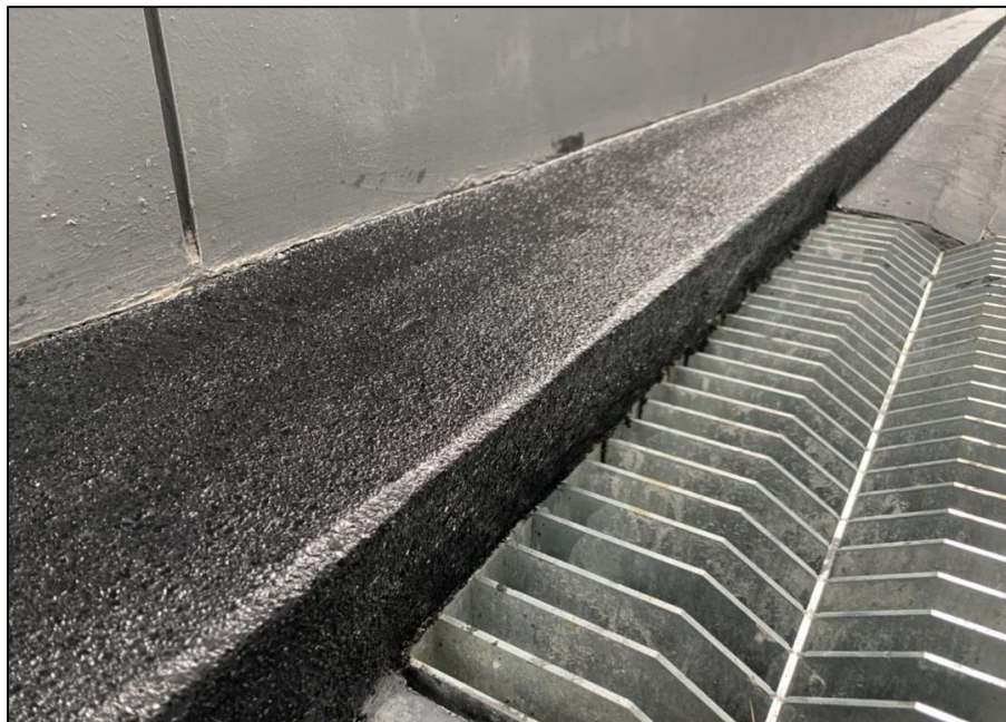
ภาพหลังเสร็จงาน
