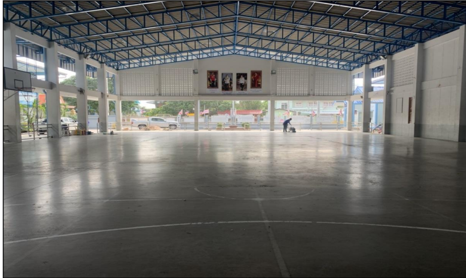
ภาพก่อนทำงาน
