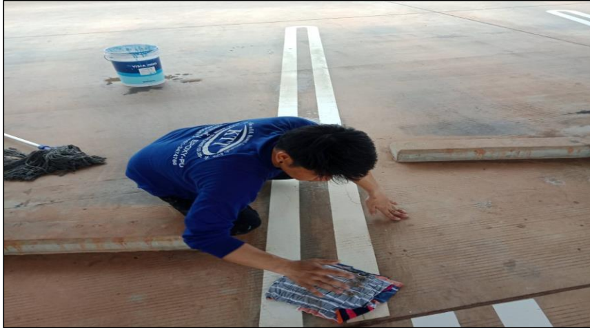
ภาพก่อนทำงาน
