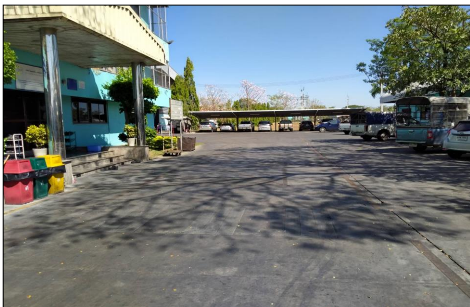
ภาพก่อนทำงาน
