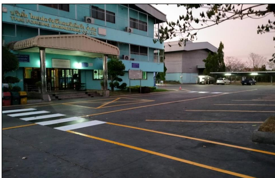
ภาพหลังเสร็จงาน
