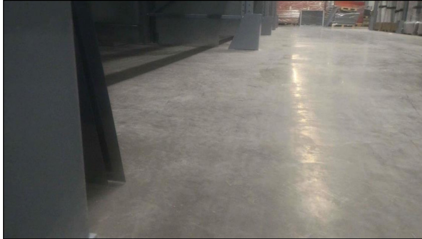
ภาพก่อนทำงาน
