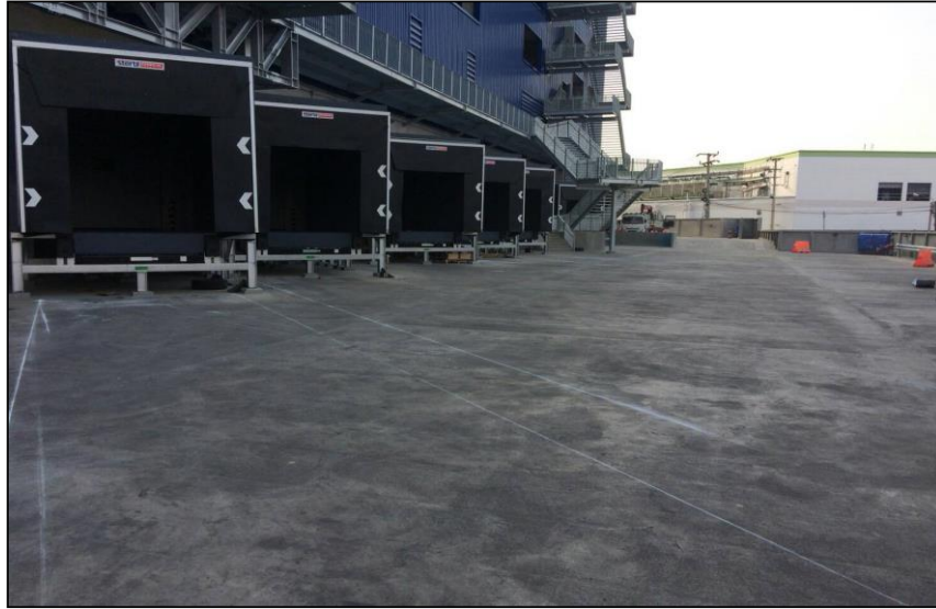
ภาพก่อนทำงาน
